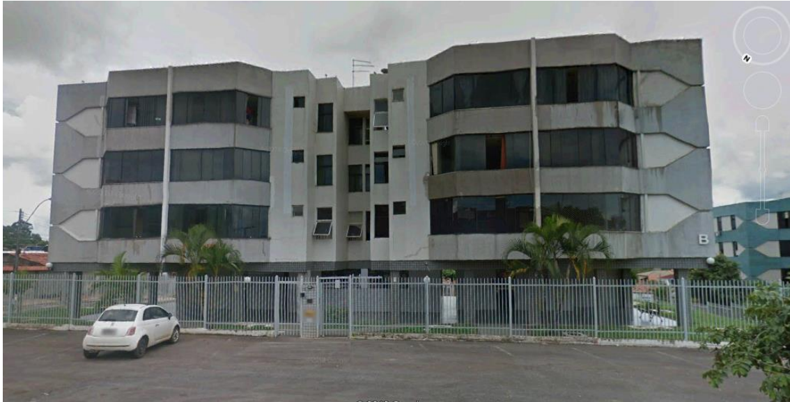
Figura 4 - Vista da fachada do Edifício Gênova.
