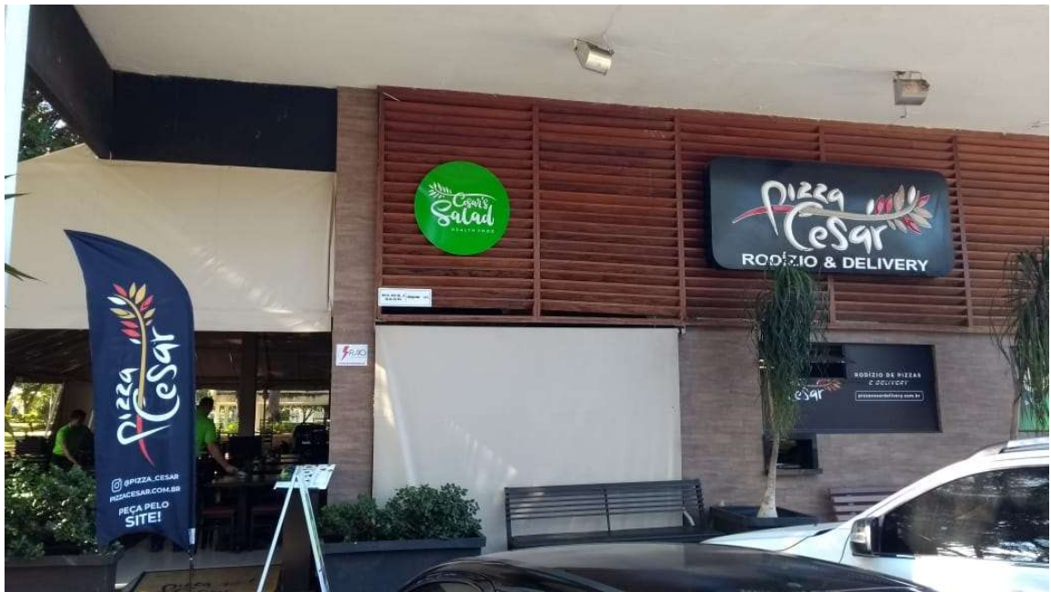
Figura 16: Fachada da operação do Pizza César a ser trabalhada Fonte: Acervo próprio (2019)
