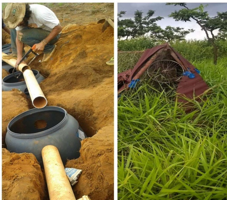
Fotografia 9: Galinheiro móvel e instalação da fossa biodigestor ao lado da nascente do Rio São Bartolomeu.
