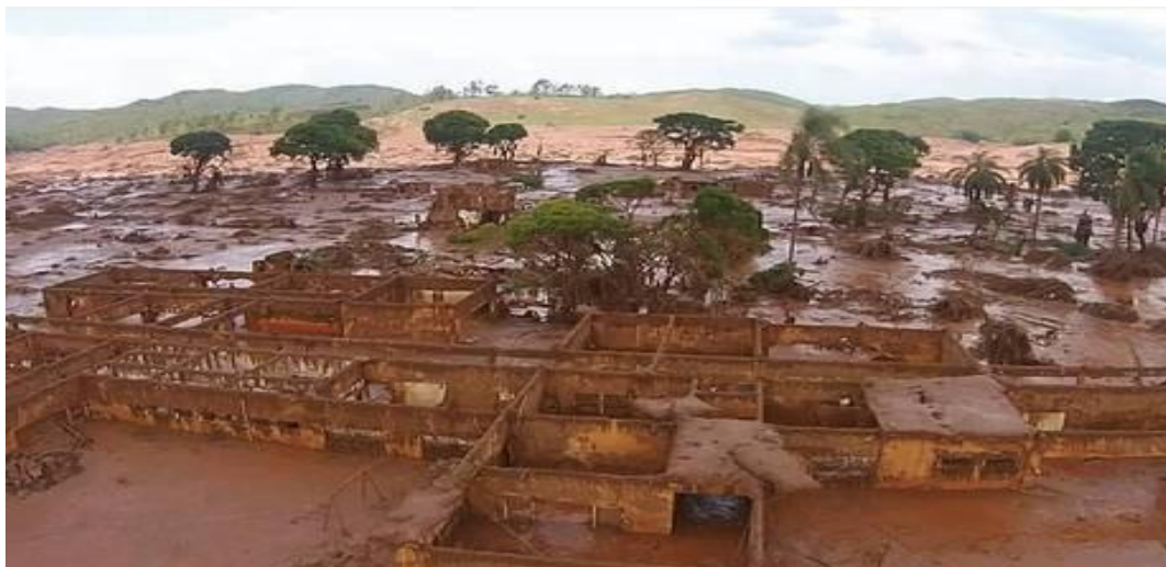
Figura 04: Rompimento da barragem do Fundão de Mariana (MG).
