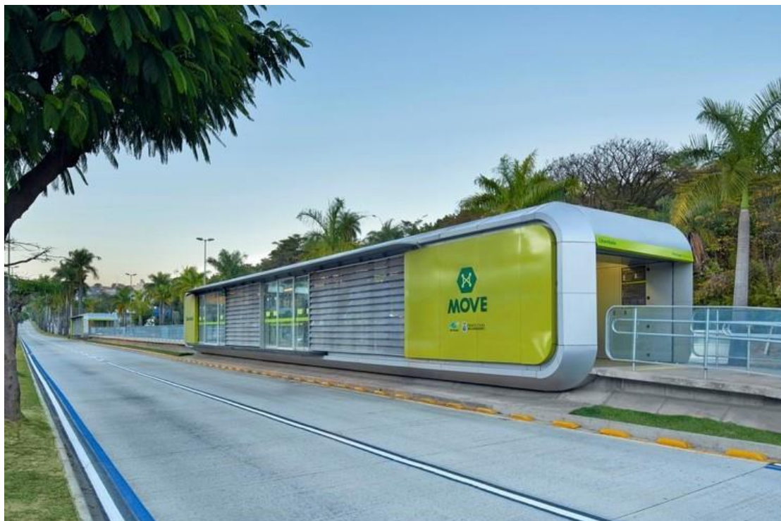
FIGURA 19 - Paradas do BRT em BH Fonte: G1 (2014)
