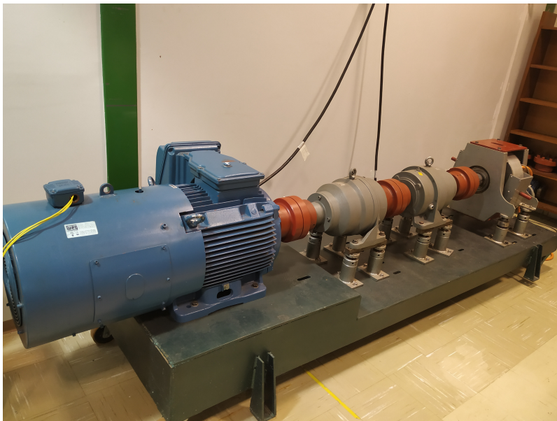
Figura 3.4: Foto do conjunto MIT (com motor de ventilação acoplado) com PMSG acoplado utilizando as duas caixas multiplicadoras.
