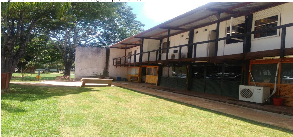
Figura 5 - Prédio da Diretoria de Segurança (DISEG)
