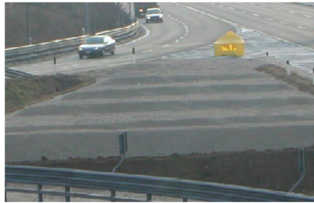
Figura 3.3: Exemplos de leitos de travagem
