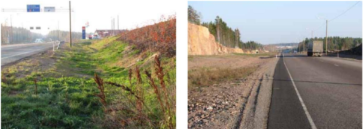
Figura 3.4: Exemplo de valas de drenagem e encostas seguras
