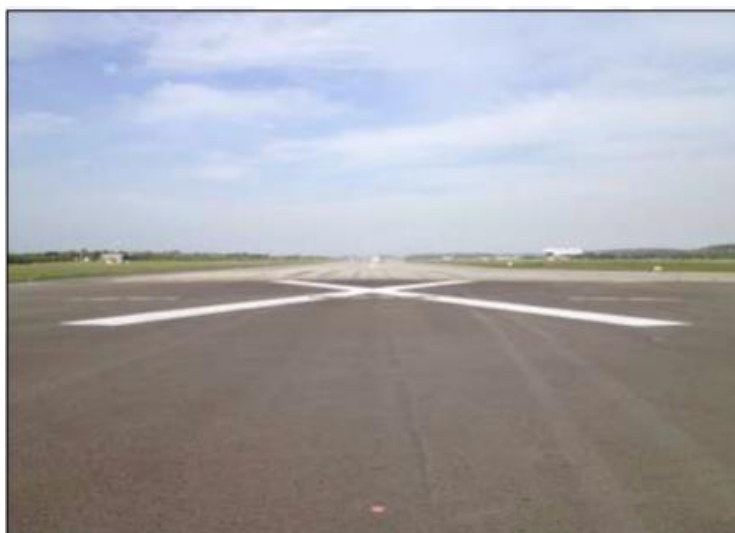
Figura 31: Sinalização da interdição da pista no sentido R10/28. Fonte: CENIPA.
