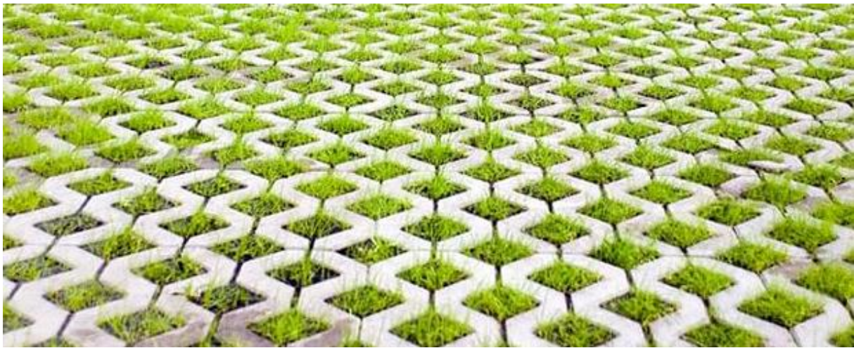
Figura 3.6 – Exemplo de pavimento permeável
