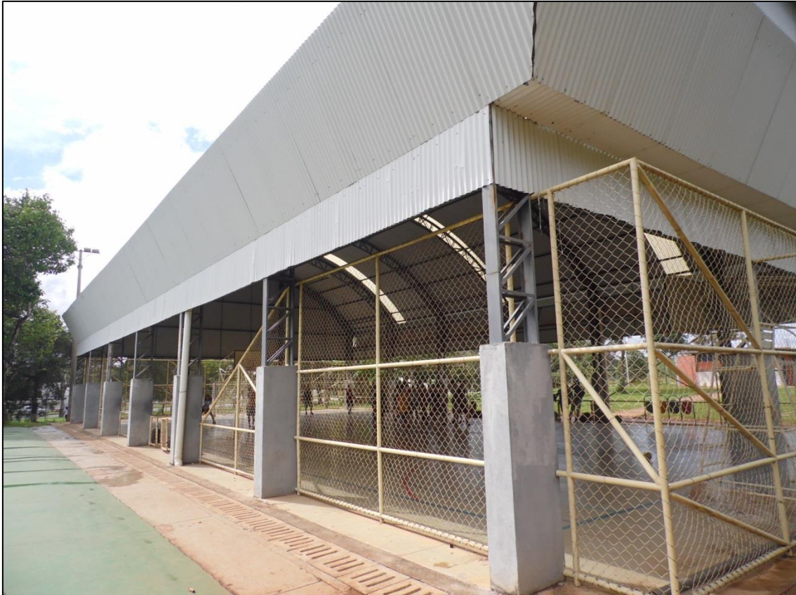
Figura 32: Cobertura do ginásio.
