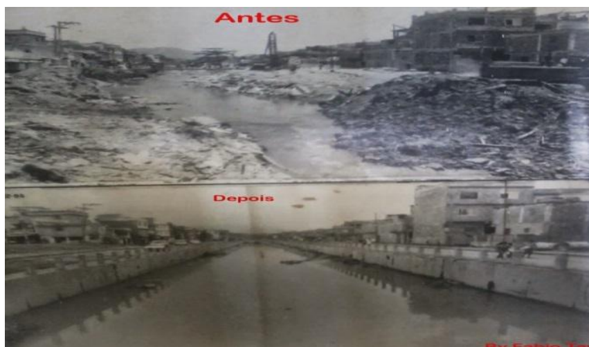
Figura 16 - Rio Jacaré antes e depois da canalização
