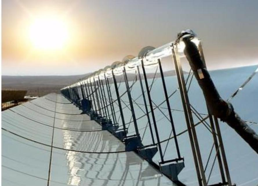
*Figura 5- Concentrador solar de linha focal: Calha Parabólica
