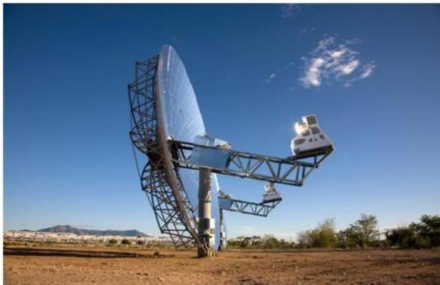
*Figura 6 - Concentrador solar de ponto focal: Disco Solar
