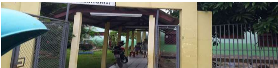
Portão de entrada
