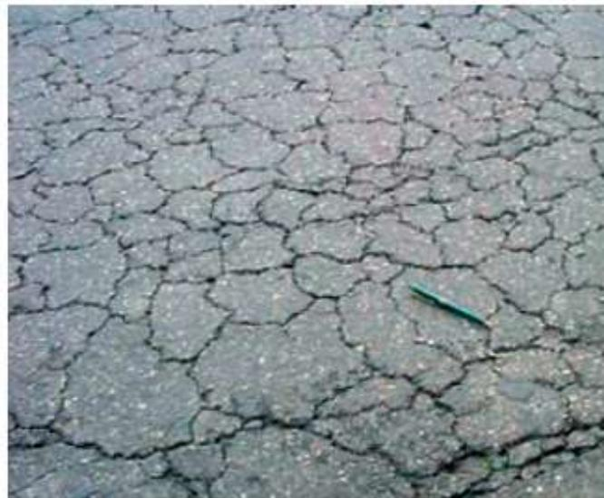
Figura 2.2 - Trincamento tipo "couro de jacaré" (Bernucci et al., 2008)
