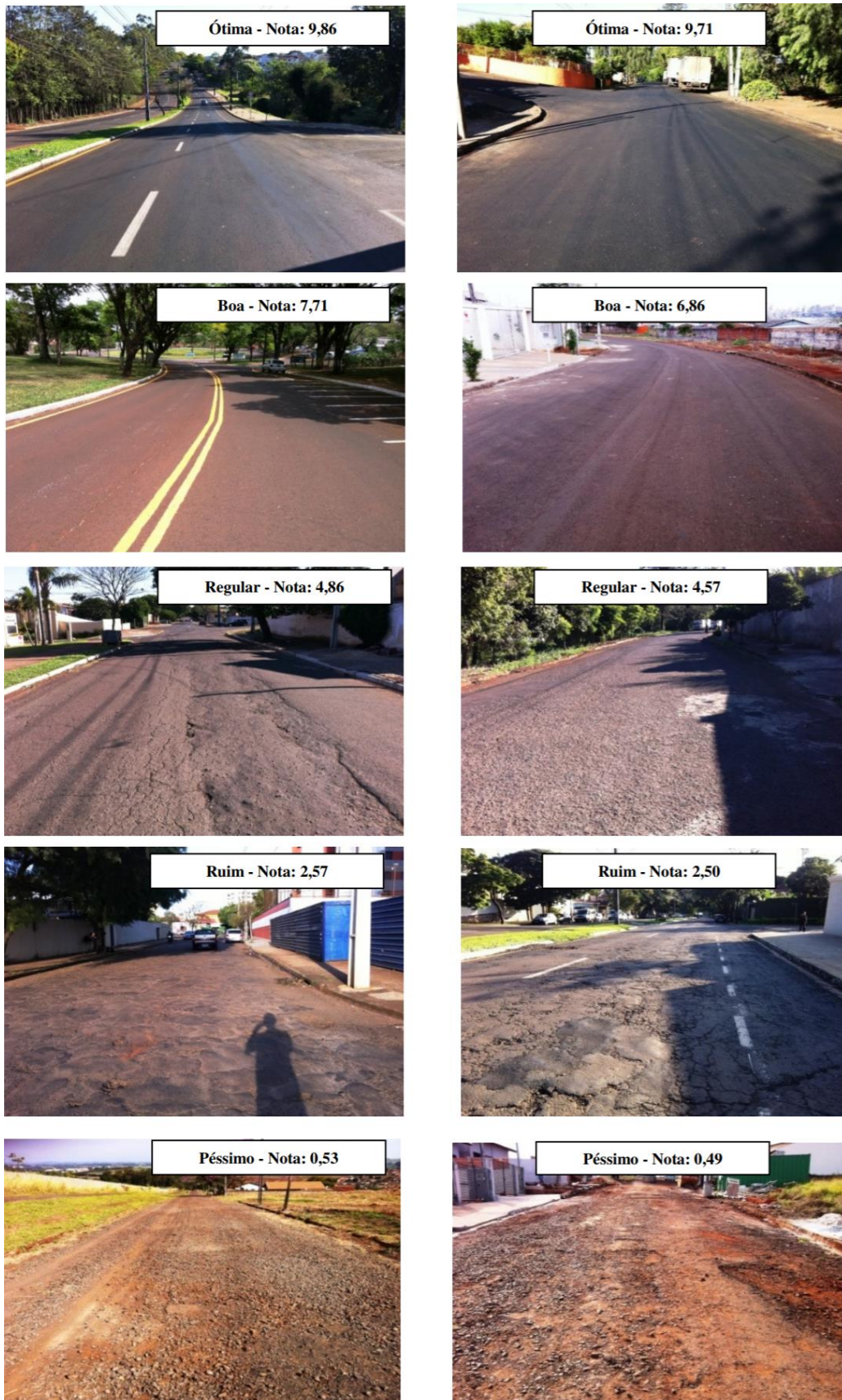
Figura 3.10 - Escala Visual para vias urbanas pavimentadas
