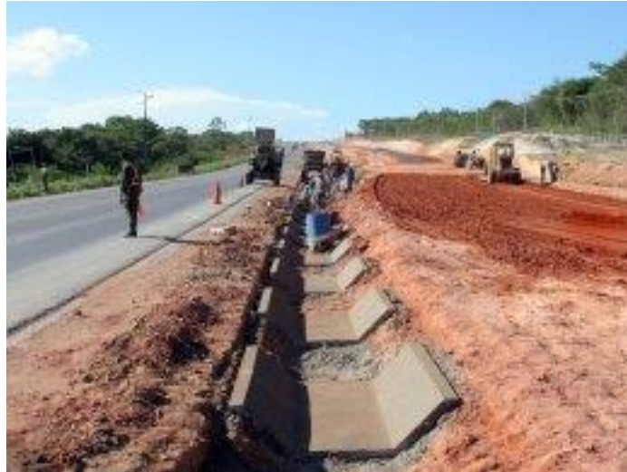
Figura 2.19: Execução de sarjeta de canteiro central
