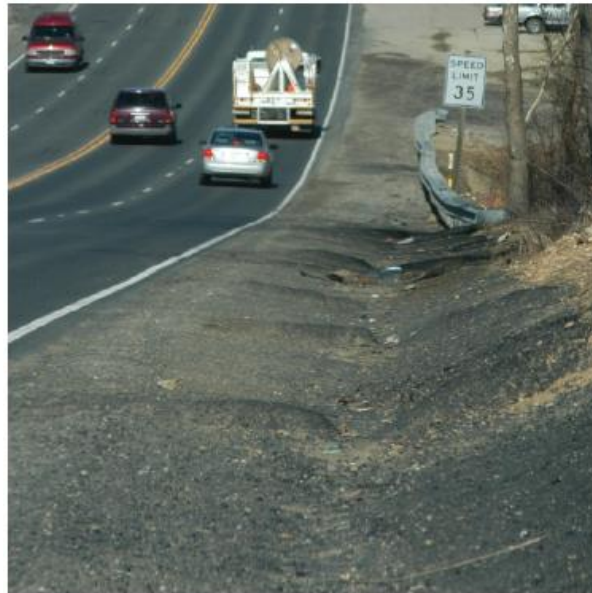
Figura 2.13: Exemplo de canal de drenagem traspassável nos Estados Unidos.
