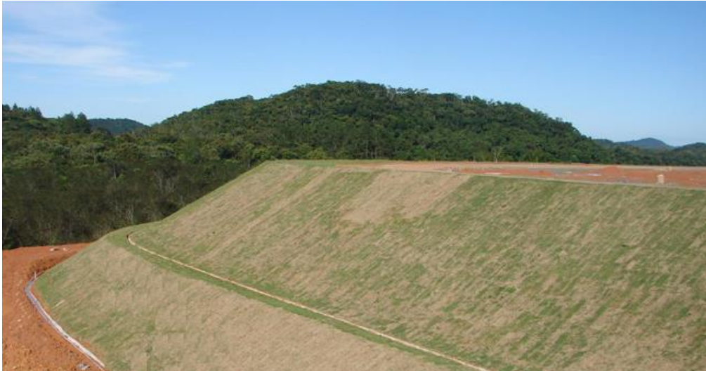
Figura 2.17: Valeta de proteção de aterro
