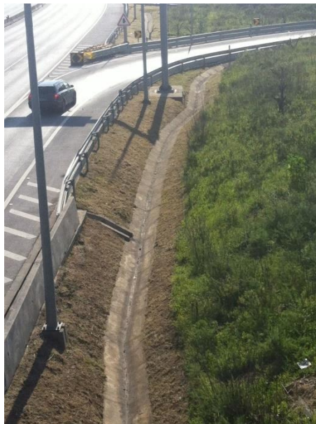
Figura 2.15: Valeta de proteção de corte
