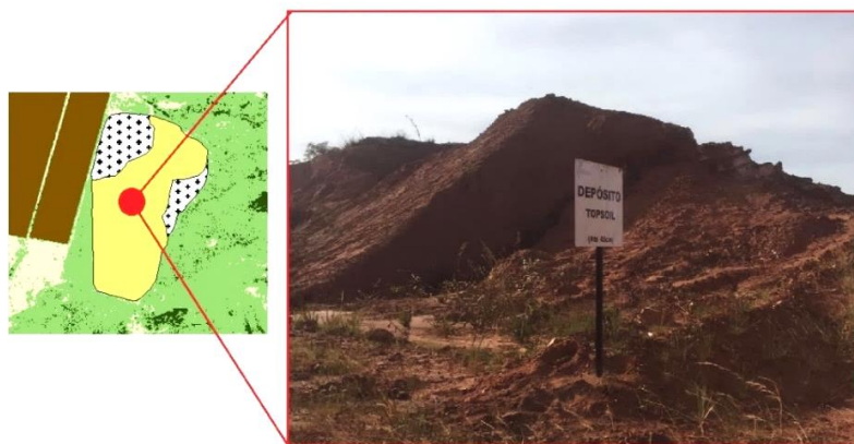
Figura 5.12: Área separada para deposição do top soil . Data: 7 de junho de 2019.
