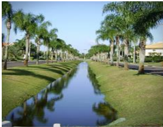
Figura 3.11: Vala de infiltração
