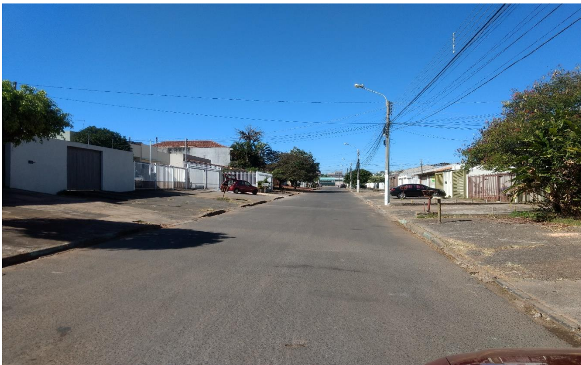
Figura 4.7: Rua residencial QSD 03 (Sub-bacia de pavimento: camada de rolamento e calçadas)
