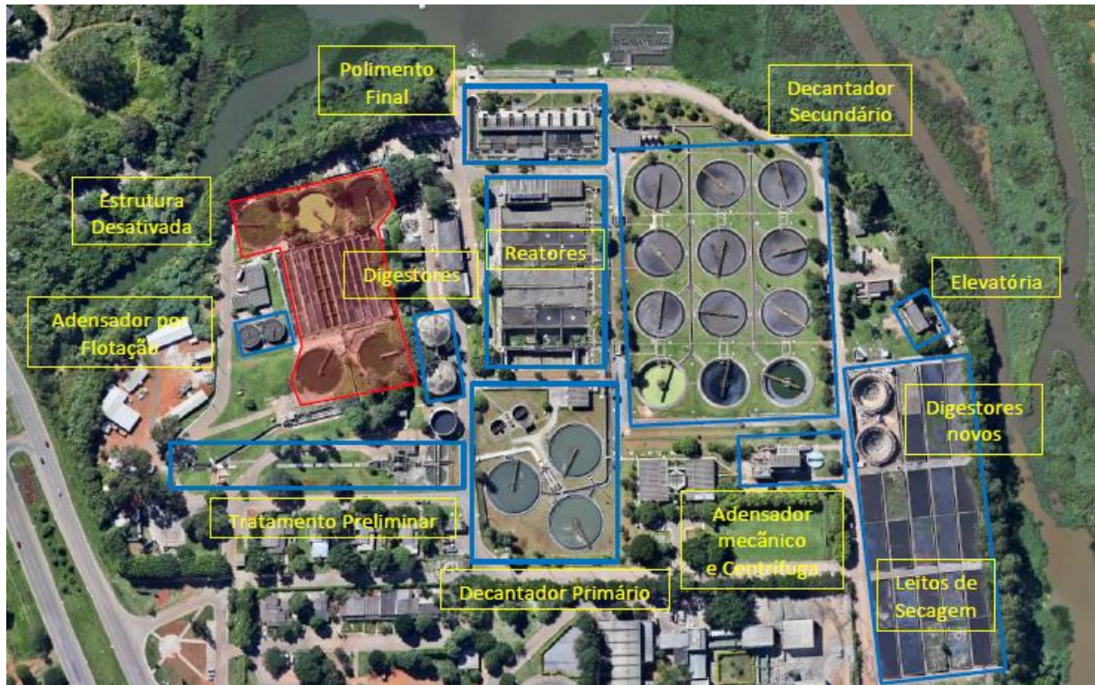
Figura 3.5.2 Área da ETE Brasília Sul. Fonte: GDF (2017)
