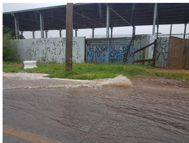
Figura 4-9: Lâmina d'água ultrapassando altura do meio fio e bocas de lobo atuando como orifícios na região Próxima à CL 316/416, na Avenida Santa Maria.
