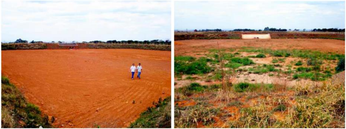
Figura 3-11: Bacia de retenção implantada na RA Riacho Fundo II (Fonte: PDDU, Concremat, 2009).
