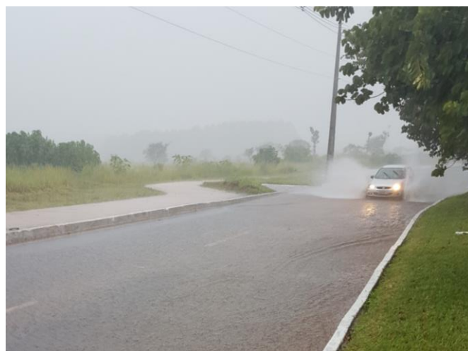
Figura 4-7: Região mais ao final da Avenida Santa Maria, apresentando empilhamento de água pluvial.
