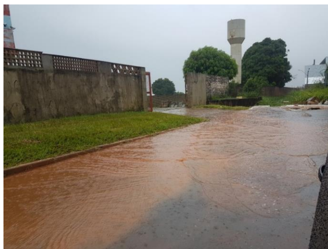
Figura 4-10: Alagamento próximo à CL 316/416, na primeira rua paralela abaixo da Avenida Santa Maria.
