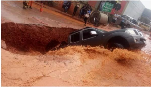
Figura 3.7 - Caminhonete em cratera aberta durante inundação em Vicente Pires (G1 1 ).
