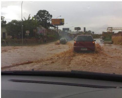
Figura 3.9 - Situação em uma das vias de Vicente Pires durante evento chuvoso (Topocart, 2010).
