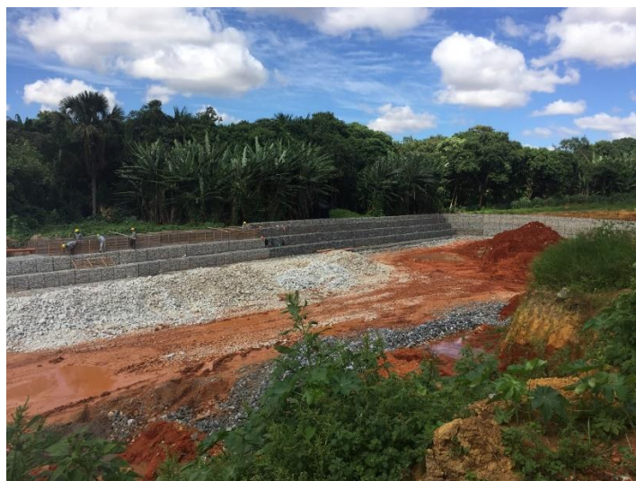
Figura 3.14 - Bacia de retenção em construção no SHVP.
