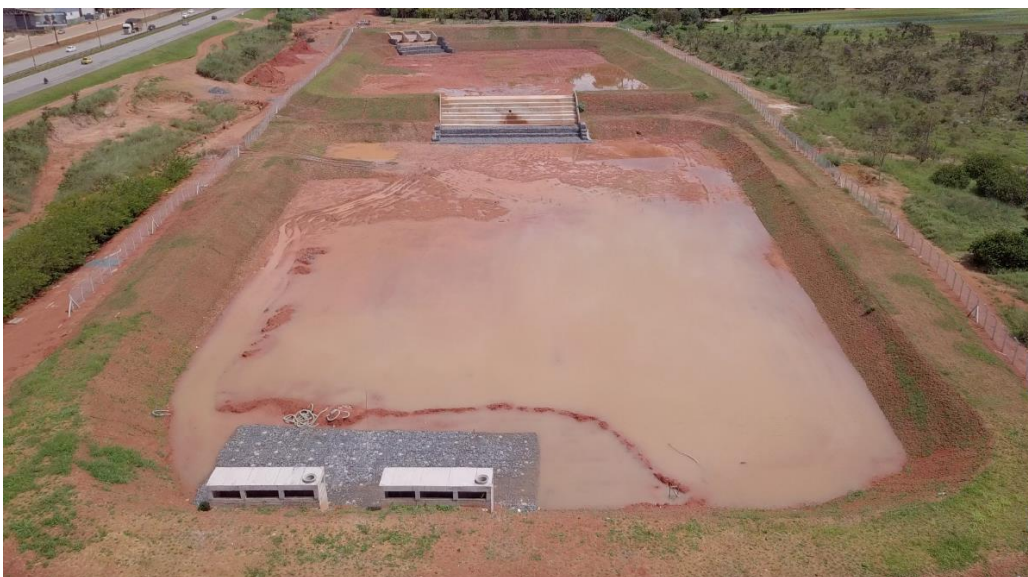
Figura 4.8 - Detalhe da entrada (a) e saída (b) da bacia de qualidade
