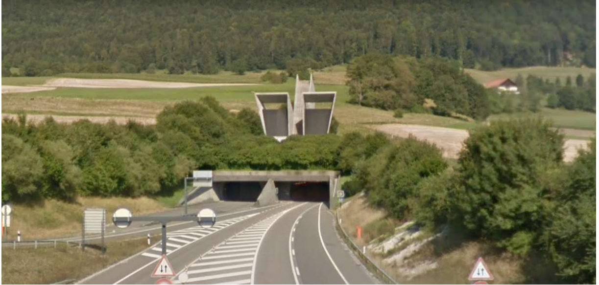
Figura 2: Acesso ao Túnel de Monte Russelin – Autoestrada nacional A16 Suíça (GOOGLE, 2013)
