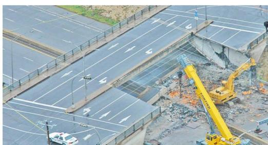
Figura 2.4 – Imagem aérea do colapso da porção sul do viaduto de la Concorde (Johnson *et al.* 2007 *apud* MITCHELL *et al.*, 2011)
