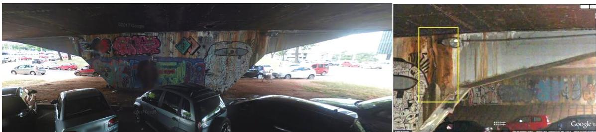
Figura 1.3 – Pilar P7 antes do colapso e detalhe da trinca no balanço. Fonte: *Google street view*
