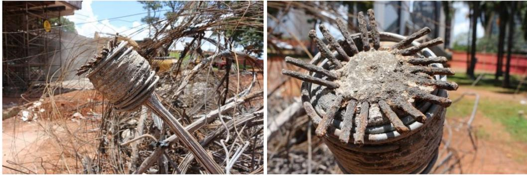
Figura 3.17 – Detalhe da ancoragem do cabo de protensão. Fonte: acervo pessoal
