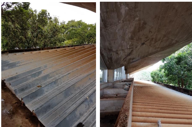
Figura 76 - Fotografias telhado perimetral 1 e 2
