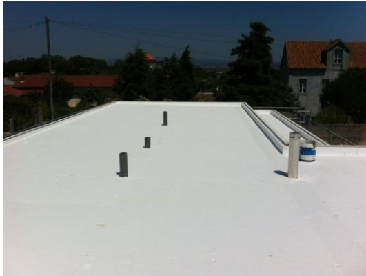
Figura 2 - Laje impermeabilizada
