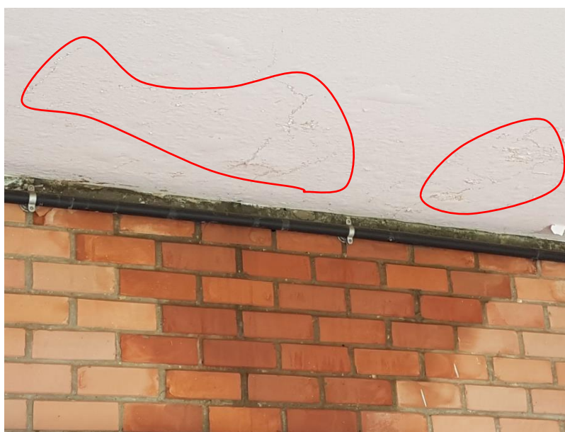
Figura 31 - Goteiras exibidas na Figura 30 em destaque – área 2
