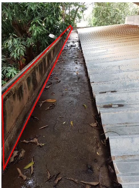
Figura 78 - Platibanda junto a calha de drenagem; platibanda em destaque
