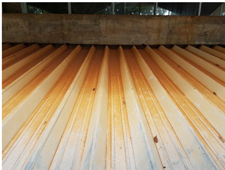
Figura 77 - Fotografia telhado perimetral 3
