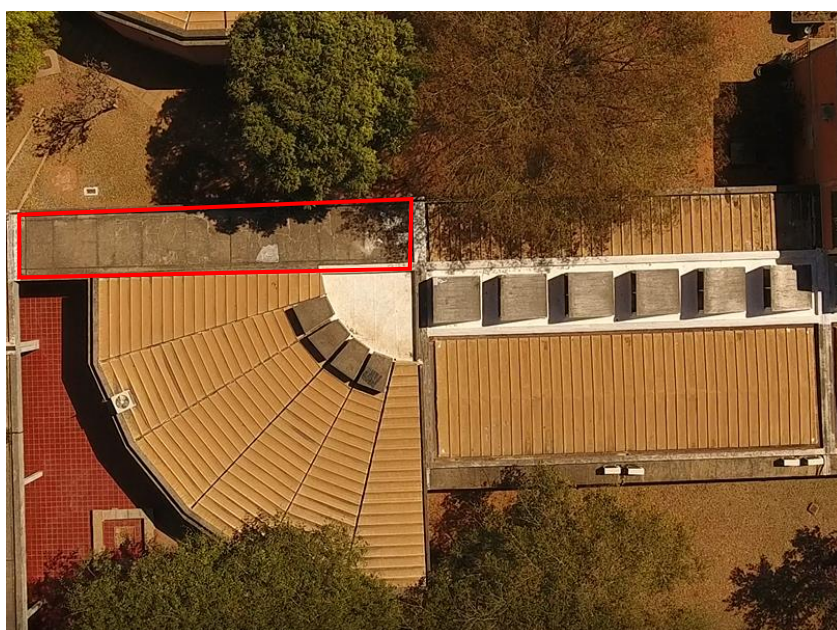
Figura 64 - Imagem VANT sobre cobertura Bloco C; área desprotegida em destaque
