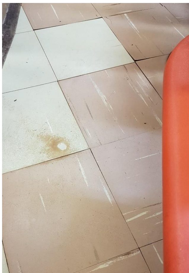
Figura 49 - Possível marca antiga de goteiras
