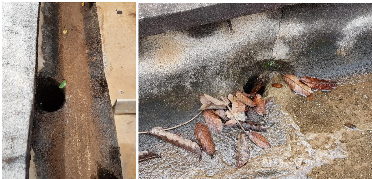
Figura 73 - Fotografias tubo de drenagem; próximo a área de foco 4 e na estrutura de suporte descoberta
