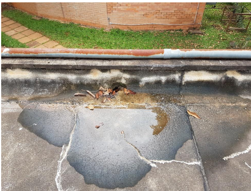
Figura 67 - Fotografia estrutura de suporte descoberta 4
