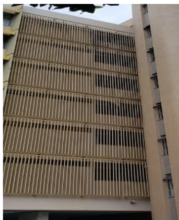
Figura 8: Exemplo de Brise nas edificações
