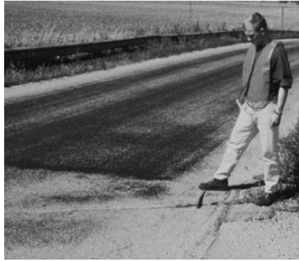
Figura 3.19 – Escorregamento com baixa severidade
