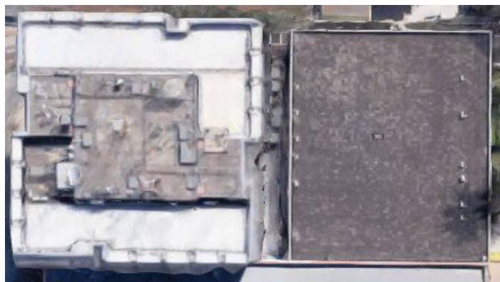
Figura 6.5 - Cobertura do BTC e Anexo (Internet)
