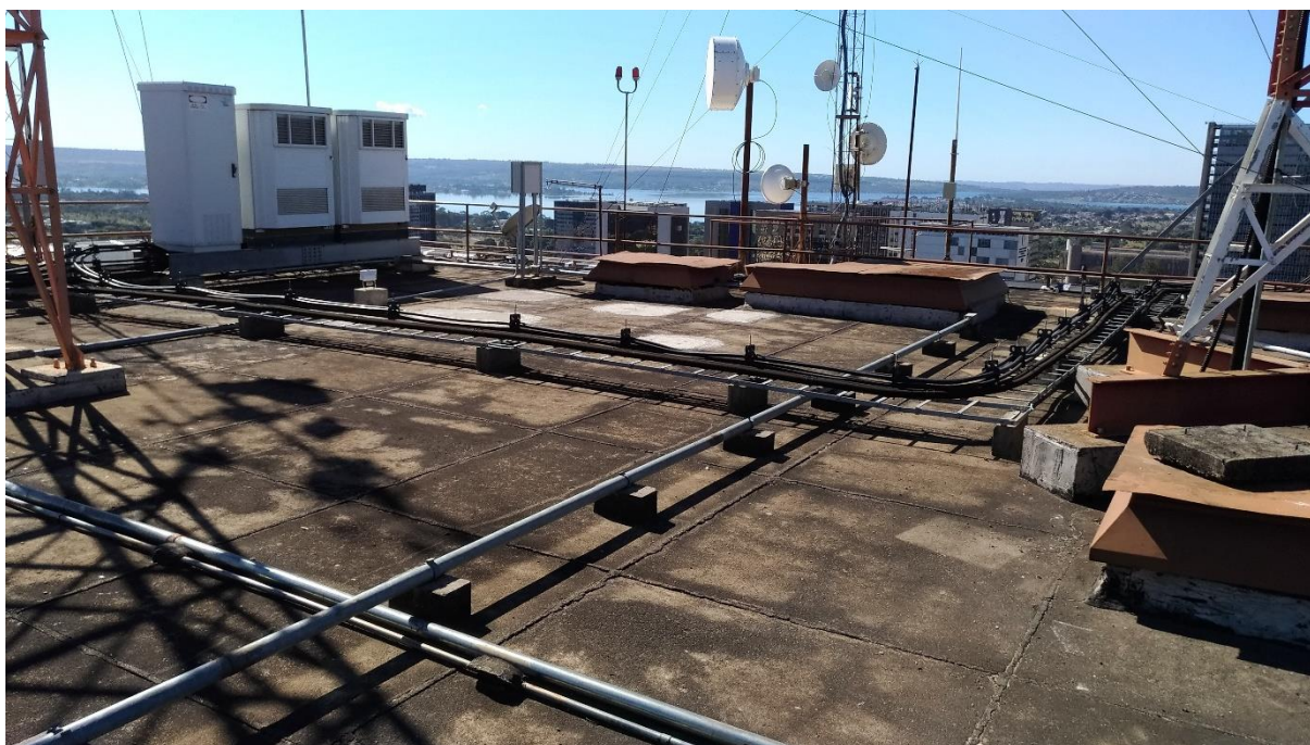
Figura 6.7 - Foto da cobertura de laje pré-moldada do edifício (O AUTOR, 2018).
