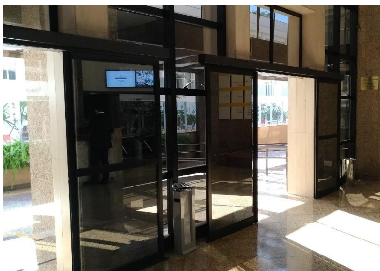
Figura 6.12 - Entradas principais do edifício (O AUTOR, 2018).
