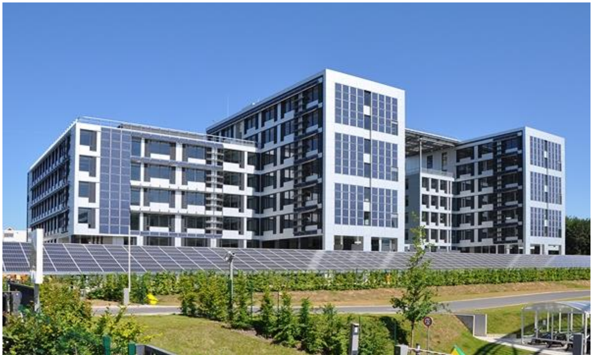
Figura 2.4 - Edifício Green Office Meudon (Green Office® Meudon, 2011).
