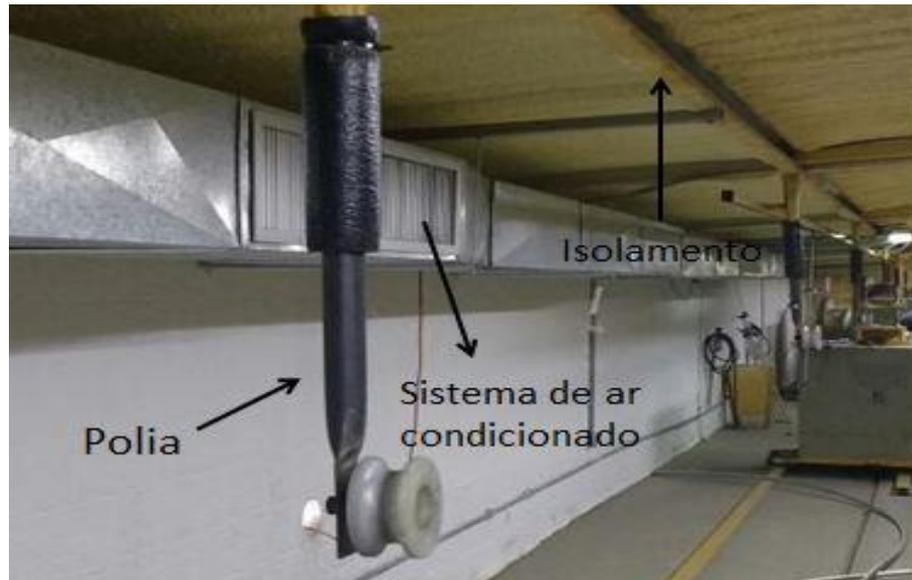
Figura 4.10 – Polias utilizadas para suportar o cabo
