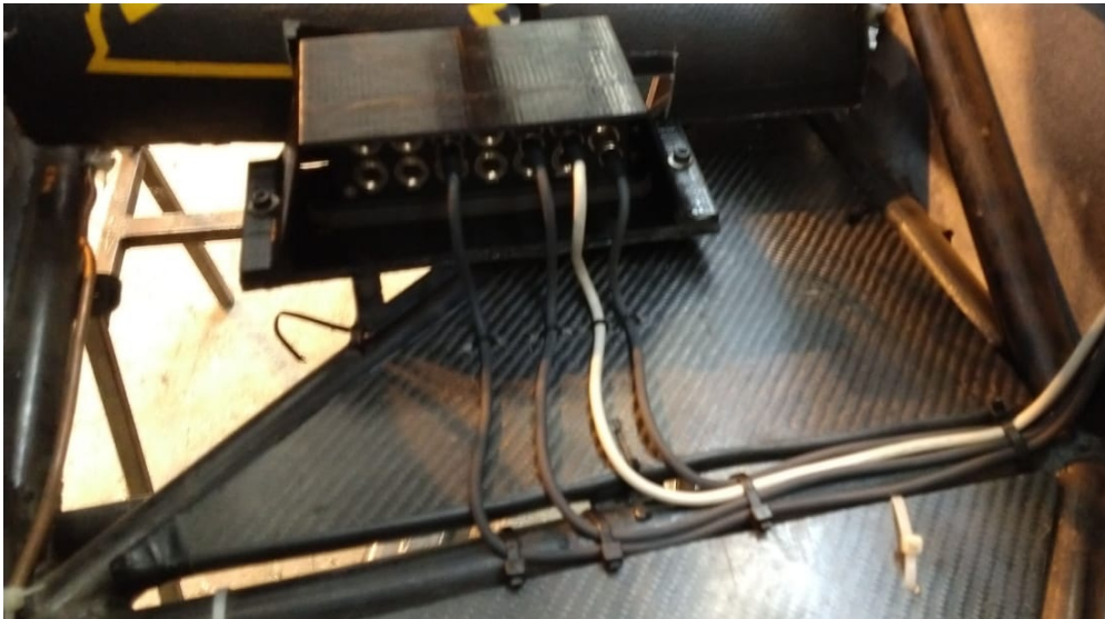
Figura 5.13: Data Logger EVO4 instalado no assoalho do AF18.
