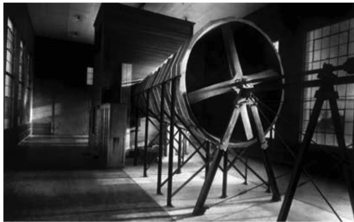
Figura 1 – Túnel de vento de circuito aberto (CHAMBERS, 2014).
