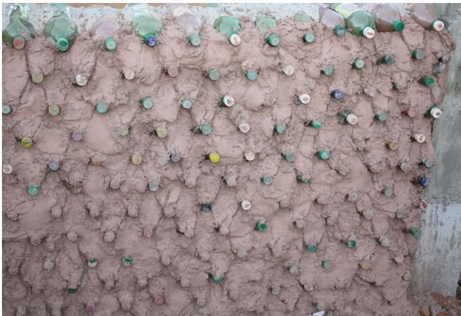
Figura 10: Reboco com massa de cimento após amarração com arame.
