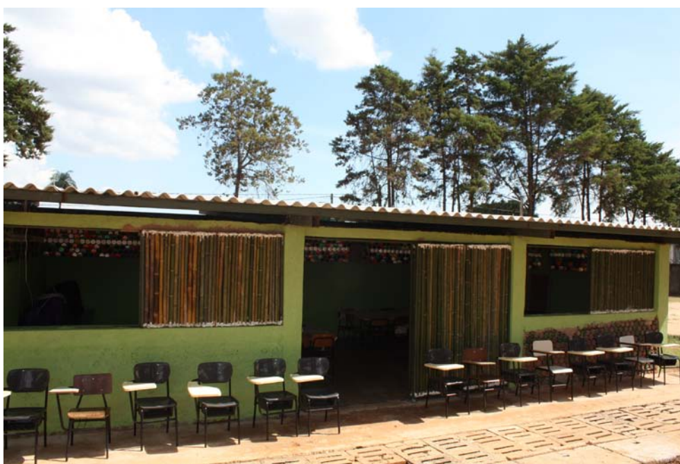
Figura 14: Sala pronta com janelas de bambú e pintada.
