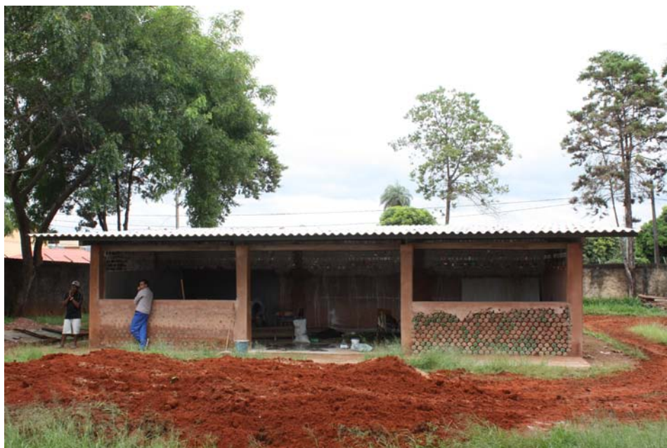
Figura 13: Sala com telhado.
