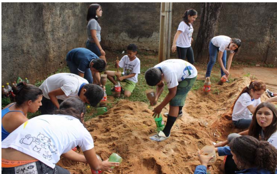
Figura 04: Enchimento das garrafas com areia.
