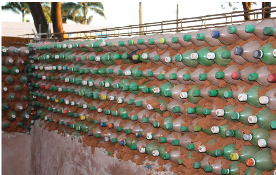
Figura 08: Travamento das paredes.
