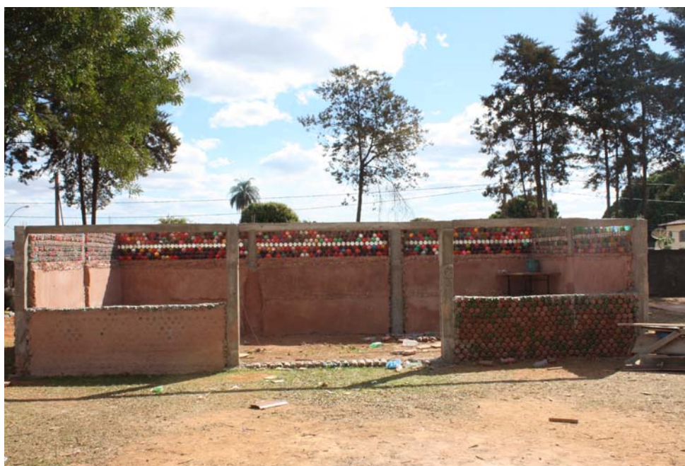
Figura 12: Sala pronta para receber o telhado.
