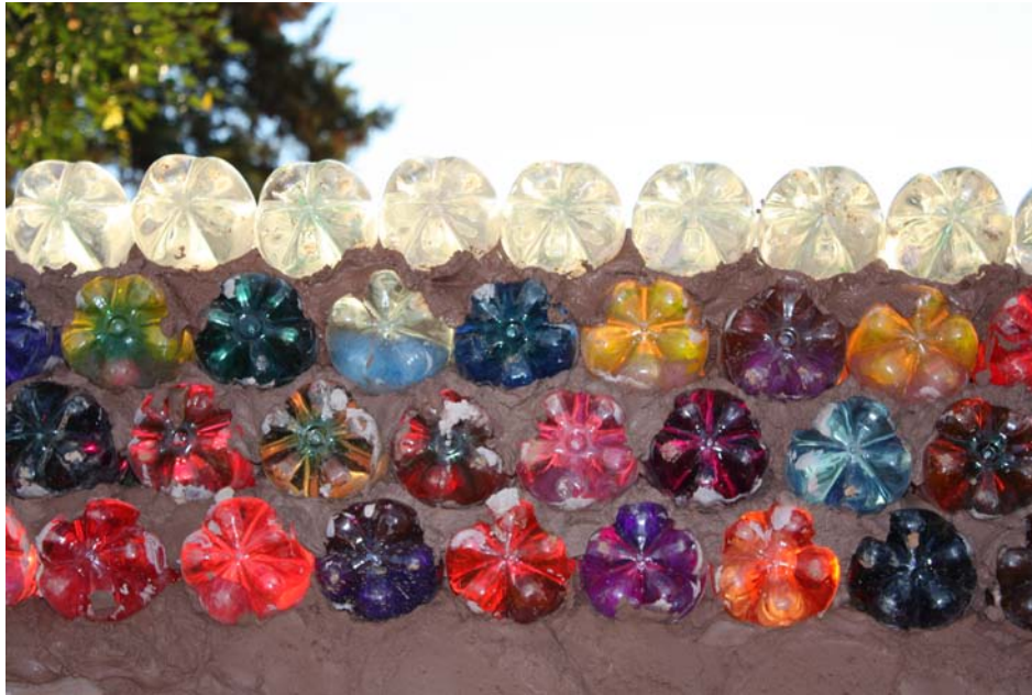
Figura 09: Garrafas com água sendo assentadas com massa de cimento.
