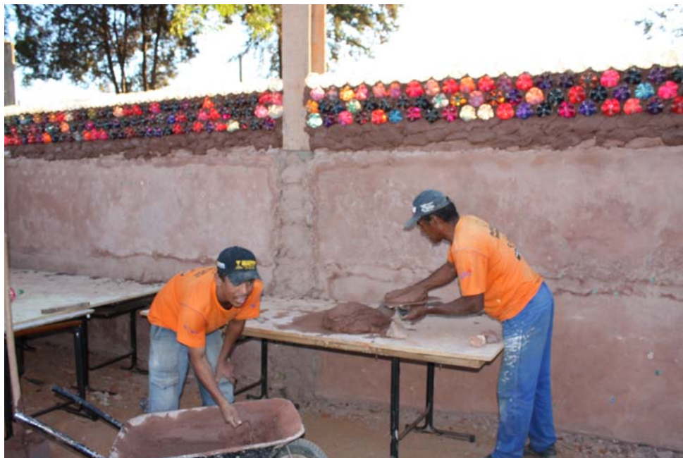
Figura 11: Reboco das paredes.
