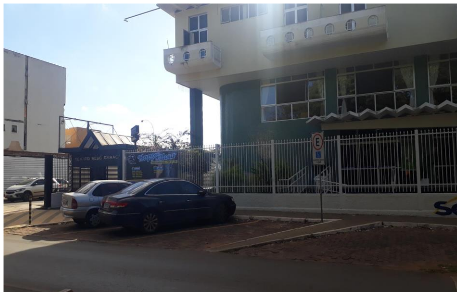
Figura 6: Rampa externa do Teatro Sesc Garagem Fonte: Dados primários
