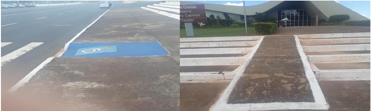
Figura 4: Rampa externa do Teatro Pedro Calmon
