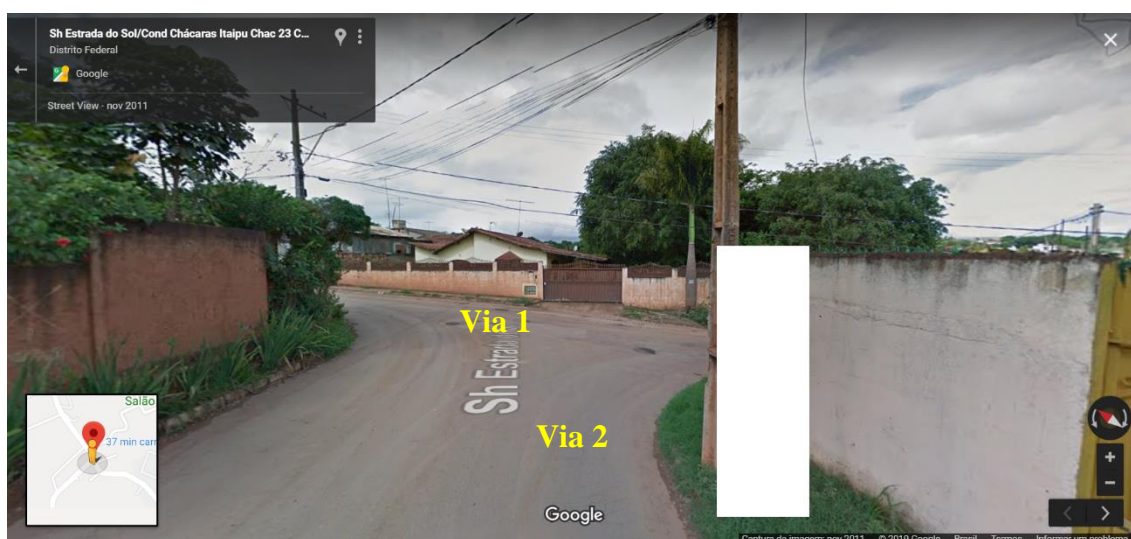
Figura 5 – Entroncamento entre a via 1 e a via 2.
