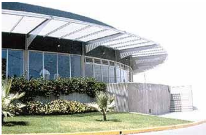
Brisas horizontais controlam a incidência de luz na face do vidro, reduzindo o calor interno
