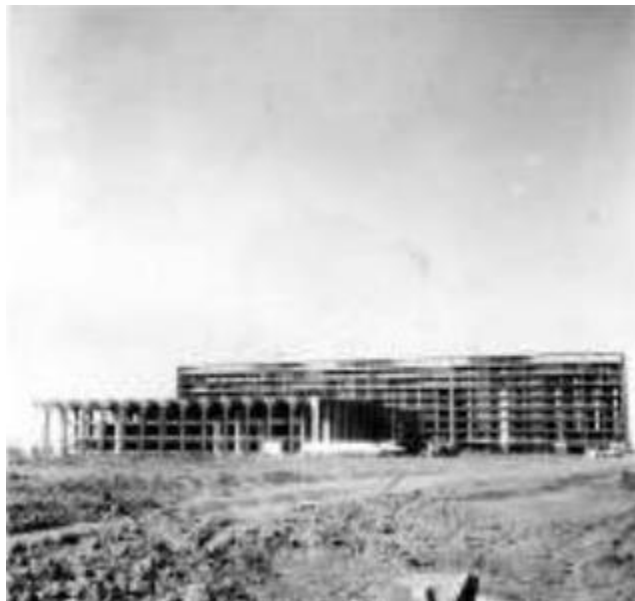
Figura 5 - Vista geral das obras em 1966
