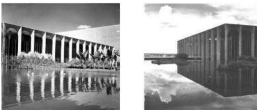
Figura 7 - Vista geral das obras já finalizadas em julho de 1971
