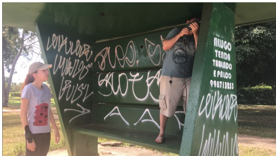
Figura 29: Perfuração do concreto armado
