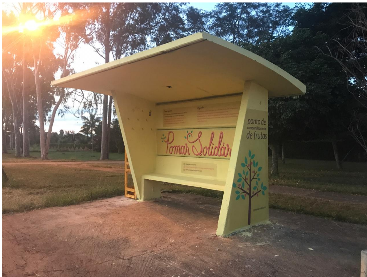
Figura 33: Resultado final da reforma do ponto de ônibus
