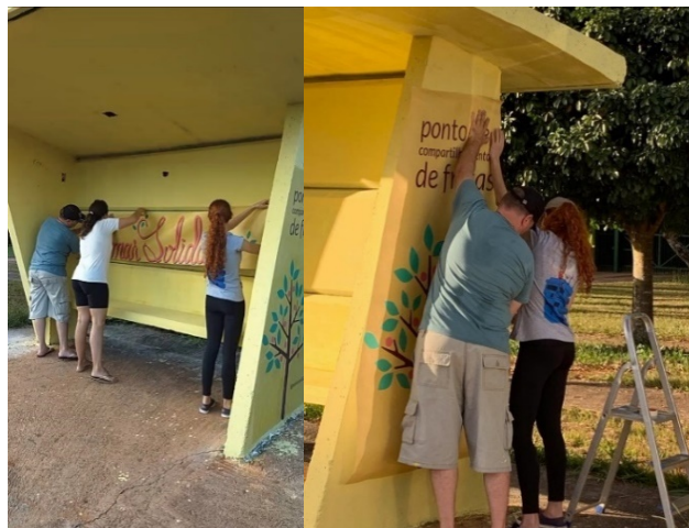
Figura 31: Colagem da sinalização
