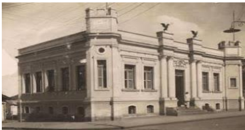
Figura 2: Imagem do prédio com as águias, década de 1940
