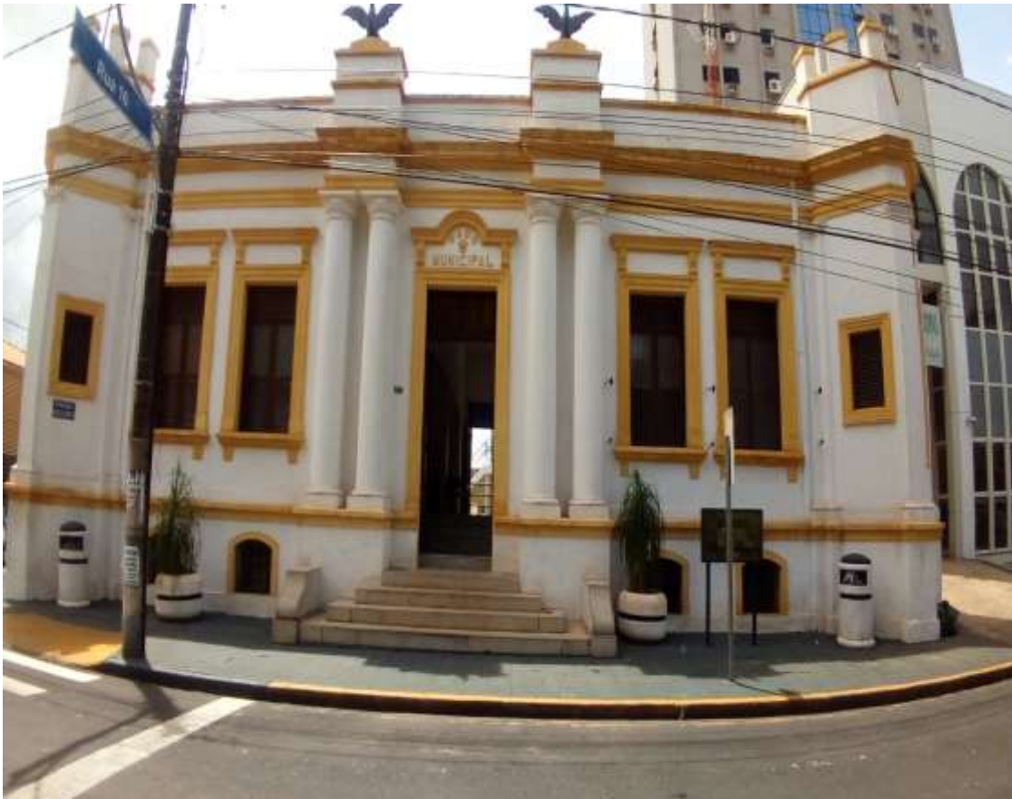
Figura 1 - Fachada do prédio do Museu Ruy Menezes - Foto: Raquel Milagres de Mattos
