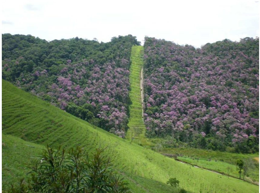
Faixa de implantação do gasoduto GASTAU
