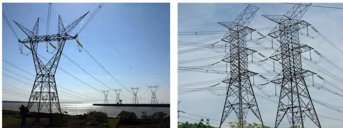
Figura 2.5 – Exemplos de Torres Autoportantes
