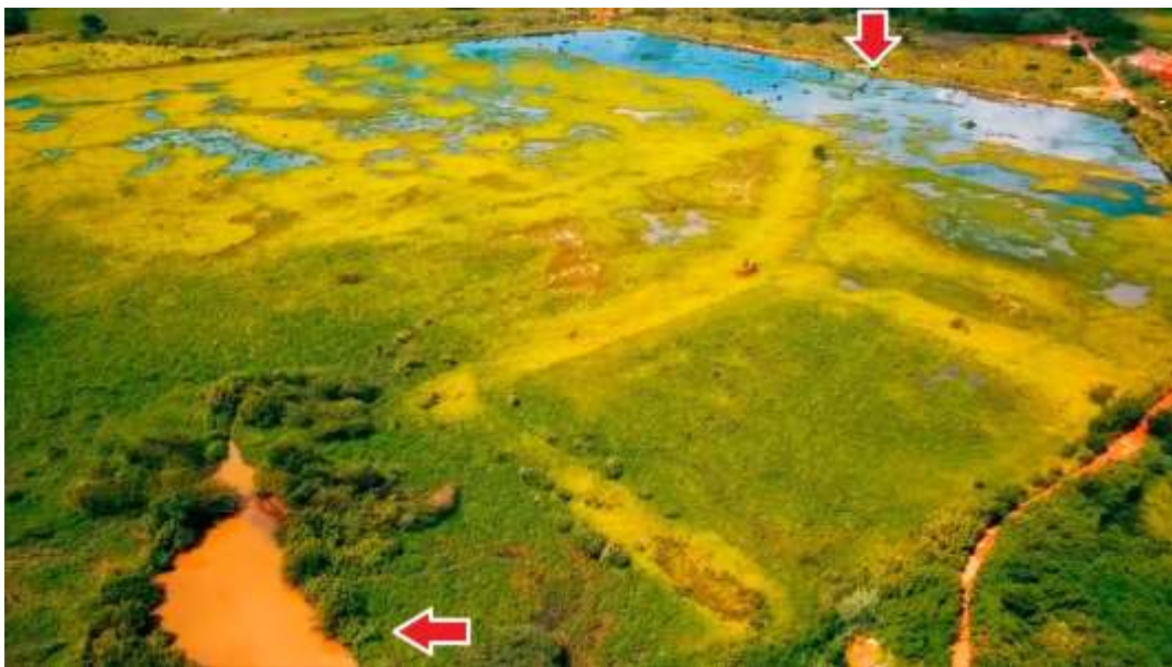
Figura 5.11 - Vista superior da bacia de retenção com grande presença de água próxima ao vertedor.
