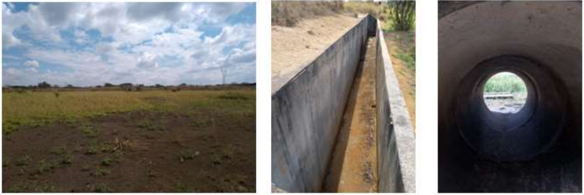
Figura 4.8 - Bacia de retenção durante época de seca: área da bacia; vertedor; orifício de saída.
