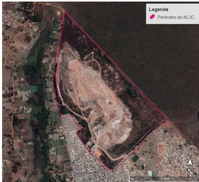
Figura 4.2 – Aterro Controlado do Jockey (ACJ) Fonte: Google Earth (2018)
