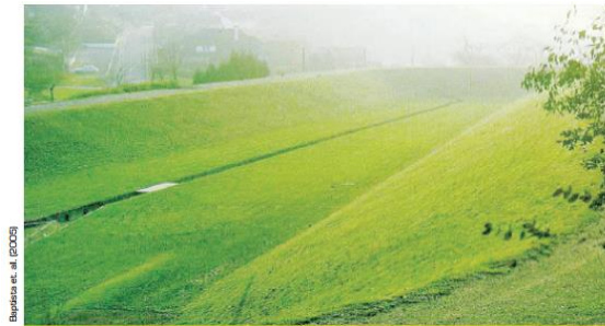
Figura 3.12: Exemplo de bacia de infiltração. (NUCASE, 2007)
