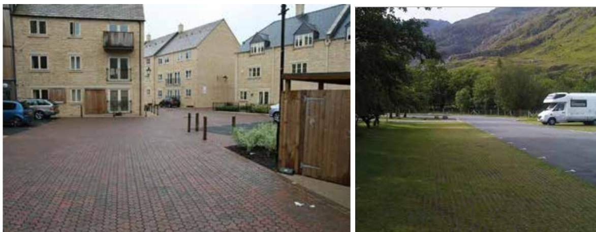
Figura 3.11: Pavimentação permeável de blocos de concreto.
