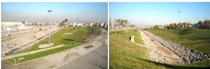
Figura 3.13: Bacia de retenção em Santiago, Chile. (Miguez; Veról; Carneiro, 2012)
