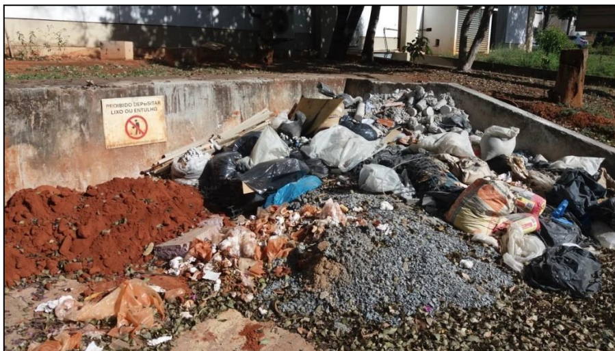
Figura 6.27 – Acondicionamento final de resíduos na baia
