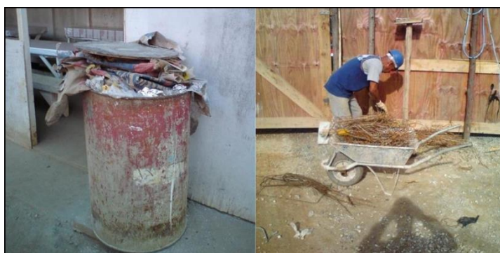
Figura 4.9 – Quantificação de RCC através de cubagem (Brum, 2013)
