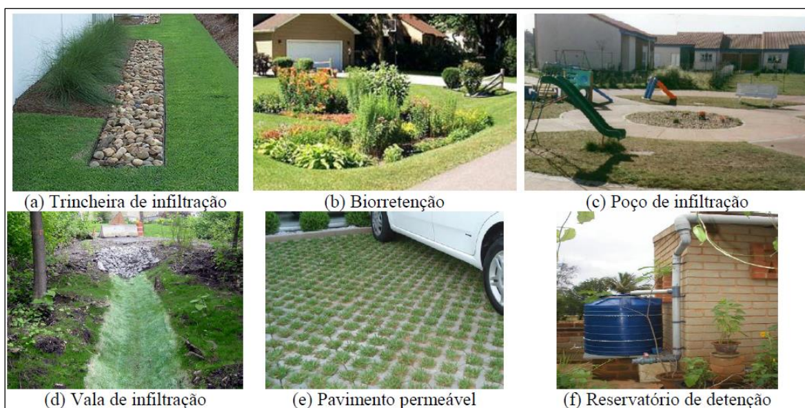
Figura 3.7 - Exemplos de diferentes técnicas compensatórias (Tassi et al. , 2016).
