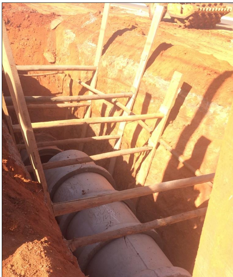
Figura 3.5 - Tubulação de drenagem sendo instalada.
