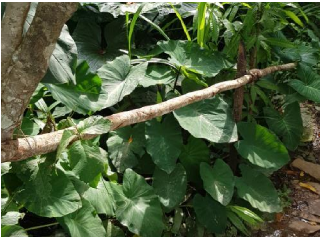
Figura 18 – “Corrimão” de apoio em trilhas, em desacordo aos padrões da norma em referência. Fonte: Pesquisa de campo, Nov/2018.
