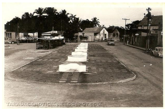
Figura 8: Praça Tarauacá, no centro. Fonte: (Foto antiga - cortesia Reginaldo Palazzo)
