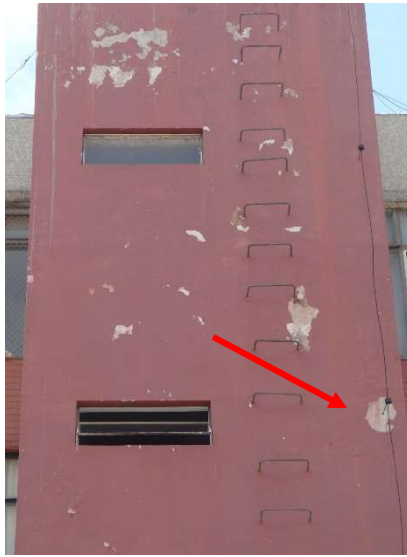
Figura 69 – Amostra DP1 de orientação Leste e defeito escolhido para observação (seta vermelha)
