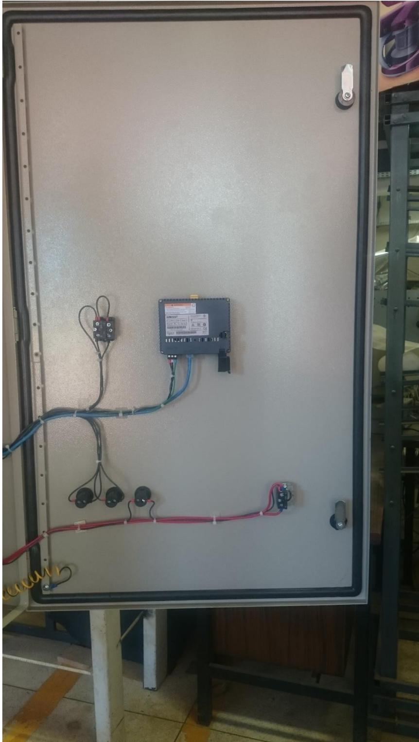
Apêndice IV.2 – Dispositivos instalados na tampa do painel de controle (vista traseira)
