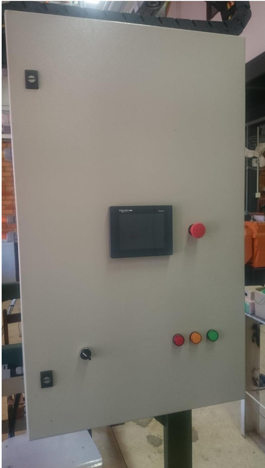
Apêndice IV.1 – Dispositivos instalados na tampa do painel de controle (vista frontal)
